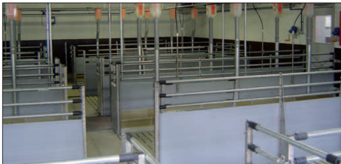
Použití zpevňujících sloupků v březárně
